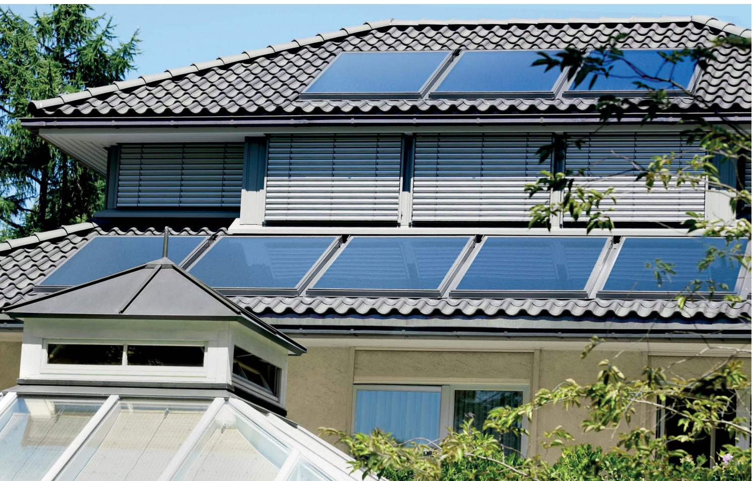
Podle stavební dispozice lze kolektory montovat pomocí originálního příslušenství Vaillant přímo na šikmou střechu domu nebo měnit jejich sklon pomocí stojanů na šikmé střeše. Další možnost je integrovat kolektory přímo do střechy nebo je instalovat volně na plochou střechu. Kolektory lze také namontovat přímo na fasádu nebo balkon, popřípadě na stojany pro změnu jejich úhlu.
