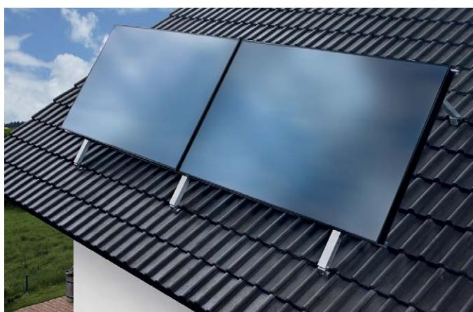
Montáž na střechu s úpravou sklonu
